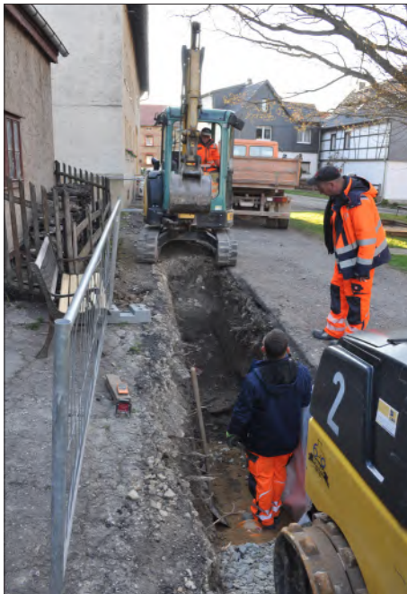
Abb. 1. Bucha. Arbeiten im Kanalgraben nordöstlich der Kirche.
